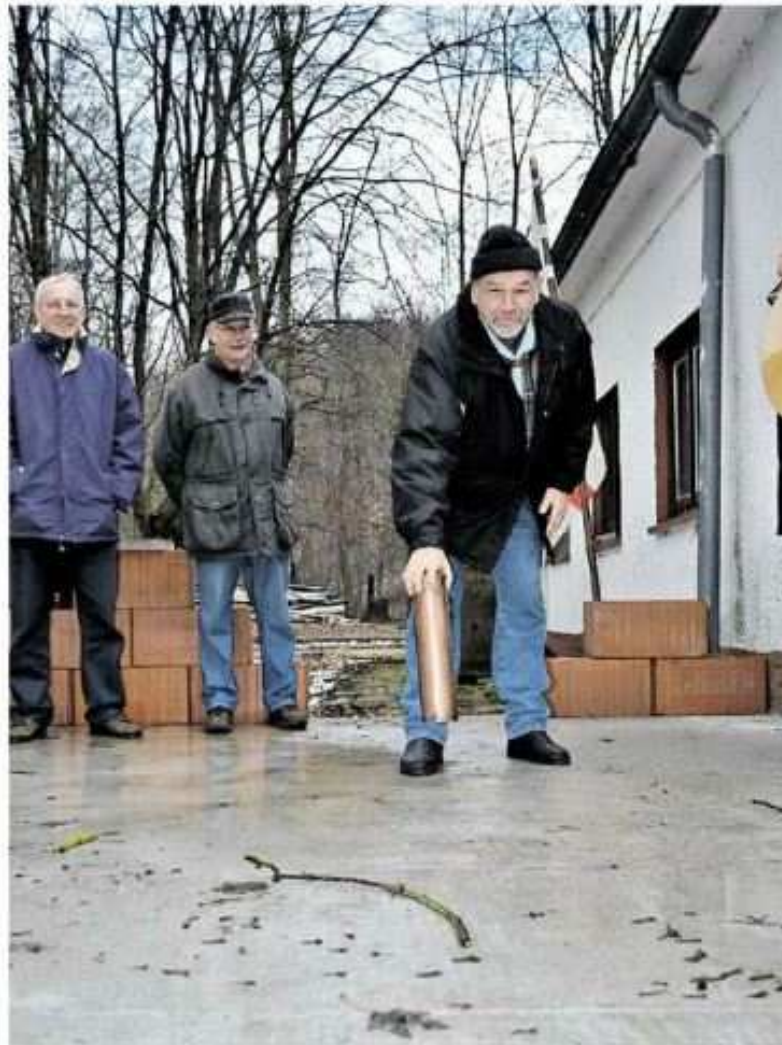
Im Frühjahr soll das Bauprojekt „Schwedenhaus“ der Diekholzer Pfadfinder Fahrt aufnehmen. Erst dann kann Franz-Heinrich Horwath vom Förderverein der DPSG die Kupferkassette mit aktuellen Daten der DPSG und des Vereins einmauern. Foto: Konrad-Nöhren
